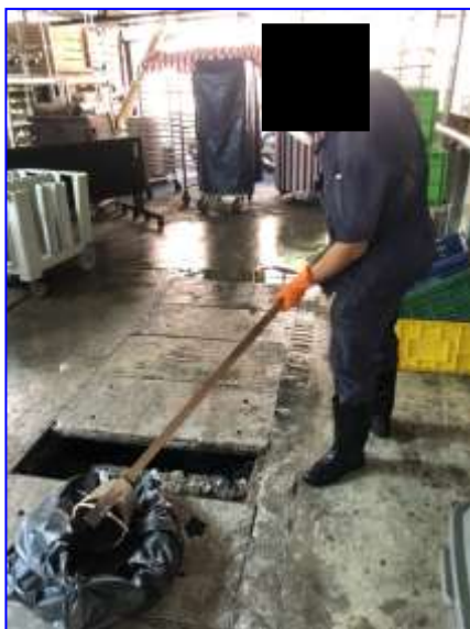
รูปที่ 2.51 การตักตะกอน
