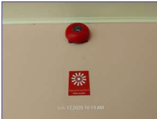
รูปที่ 2.34 Alarm Bell และ manual pull station
