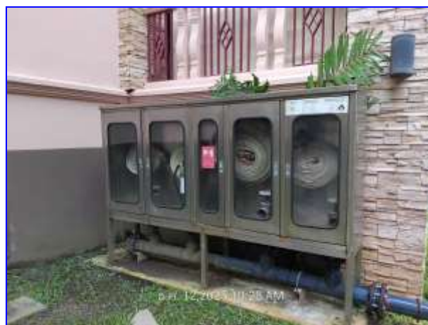
รูปที่ 2.59 สายฉีดยาดับเพลิง ขนาด 1 นิ้ว ยาว 30 เมตร จำนวน 2 เส้น
